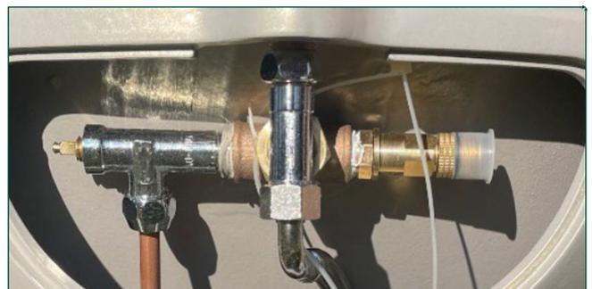
mit Absperrhahn und Regulierung der Dauerspülung / Durchflussmenge
