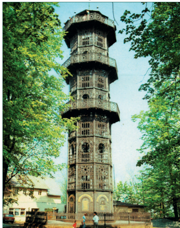
1995 Gusseiserner Aussichtsturm Löbau Nachguss der beschädigten Teile GU/Bauleitung: Fa. Fach und Werk, Leipzig
