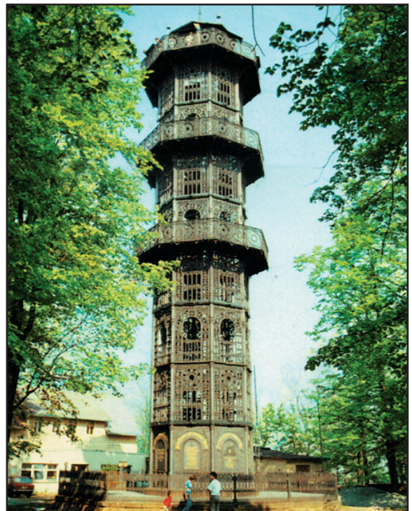
1995 Gusseiserner Aussichtsturm Löbau Nachguss der beschädigten Teile GU/Bauleitung: Fa. Fach und Werk, Leipzig
