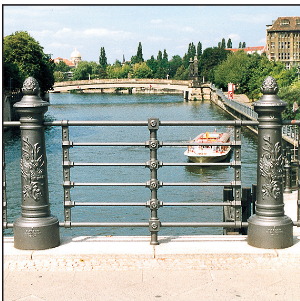
UG 06 – Liebknechtbrücke Berlin
